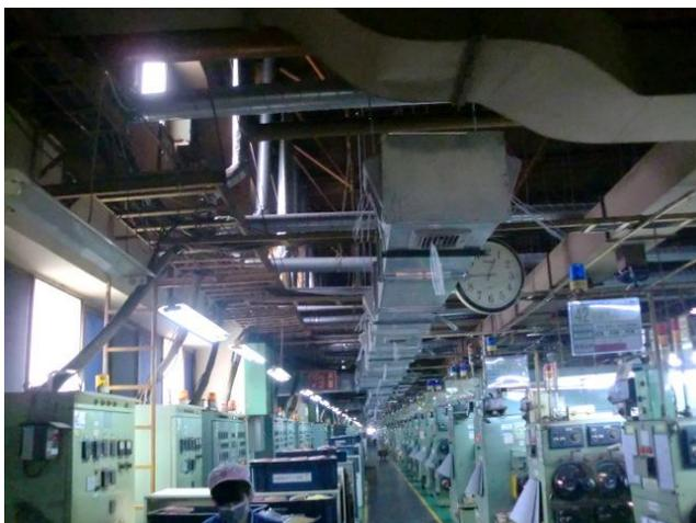
图 9：2014 年建设的工厂内部通风换气设施
