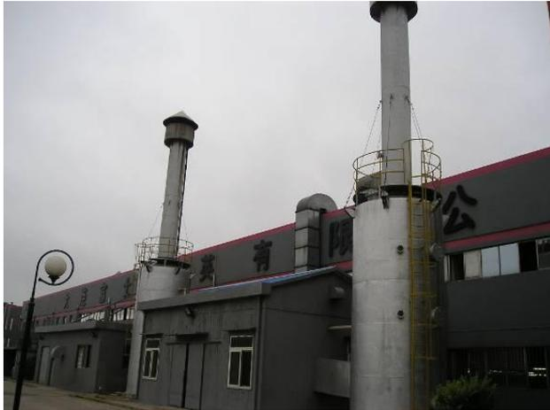
图 1 2005 年建设的工艺废气洗涤处理设施
