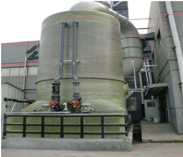
图 3 2011 年改造的废气碱水洗涤处理设施
