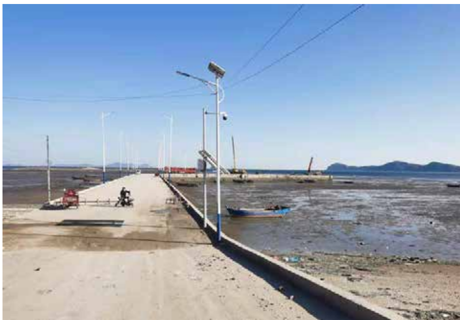
图 2-3 码头现状照片
