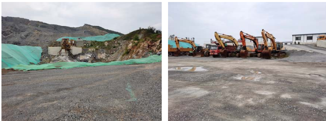
图 1: 现场勘查照片
