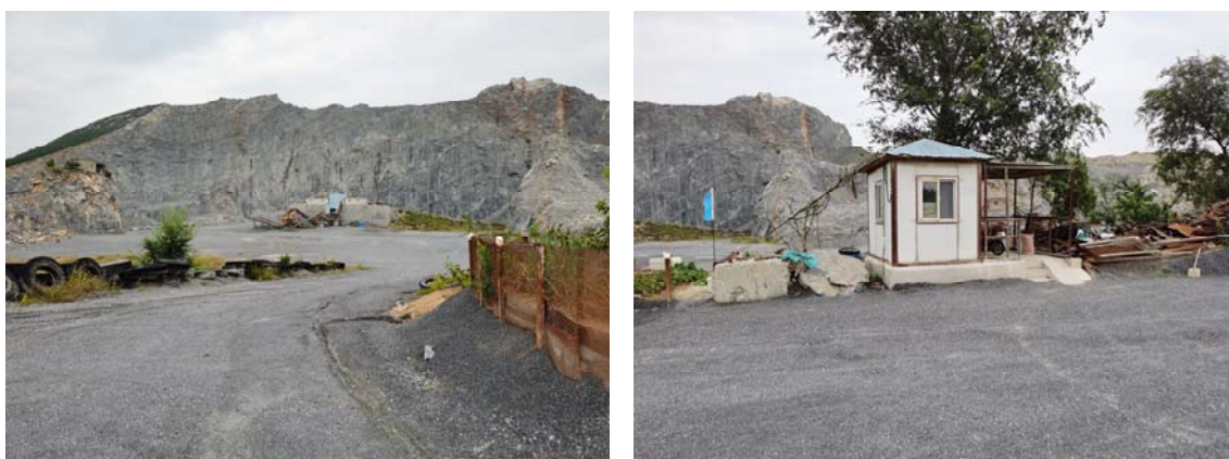
图 1：现场勘查照片
