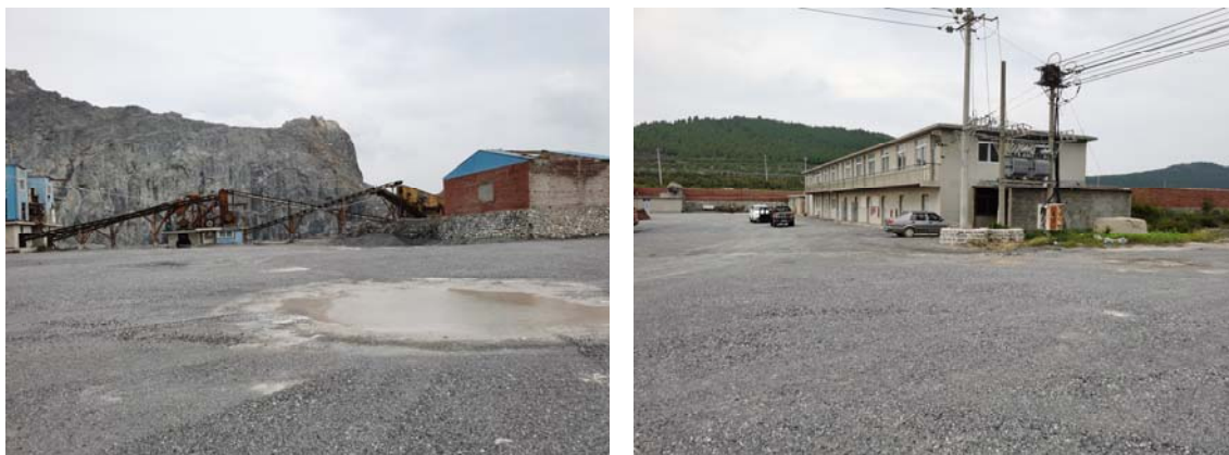
图 1: 现场勘查照片
