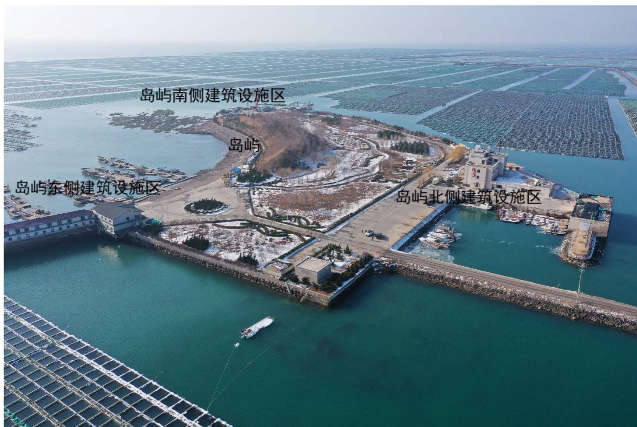
图 3.5.2-4 西沙坨子岛现状照片（2024 年 1 月）
