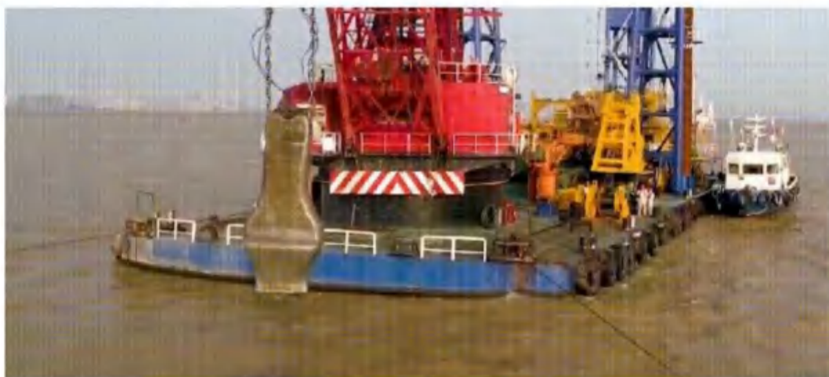
图 2.3.2-2 挖泥船释放凿岩棒示意图
