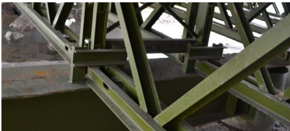
图 3.2.6-6 贝雷梁与承重梁连接意图
