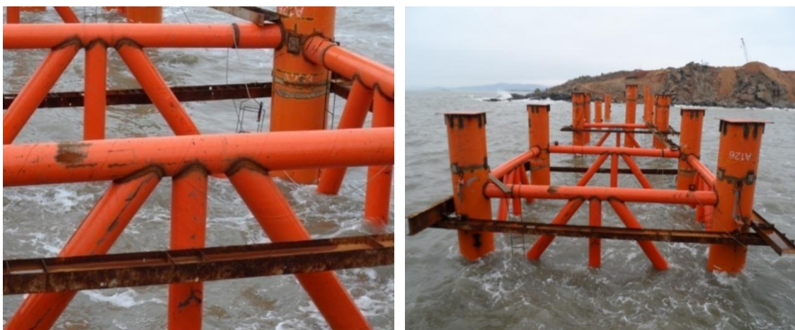
图 3.2.6-5 连接系安装示意图
