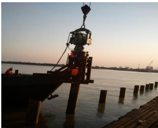
履带吊施打钻孔平台钢管桩
